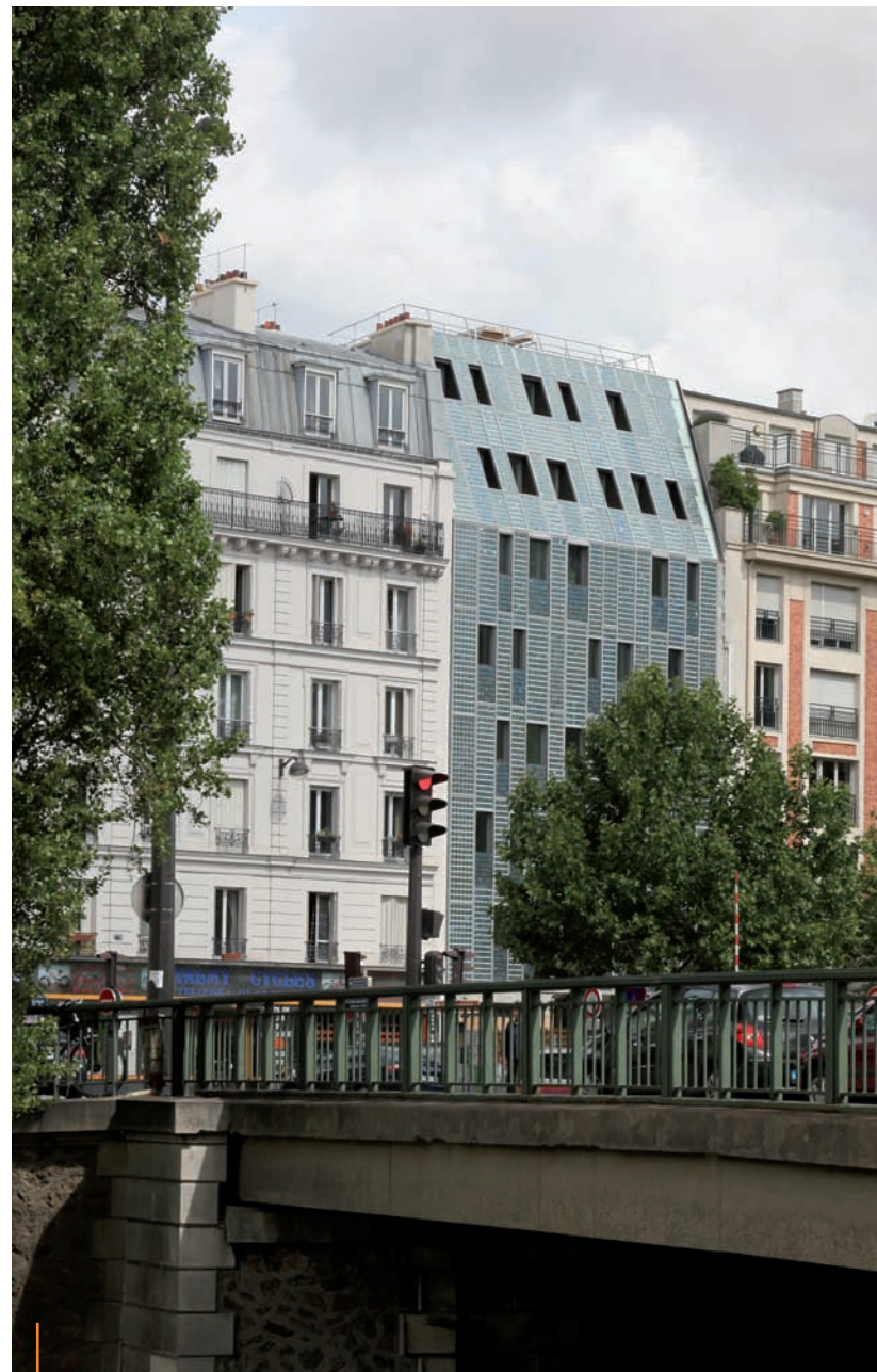
Immeuble d'habitation avec façade de panneaux photovoltaïques, Paris 10 e
