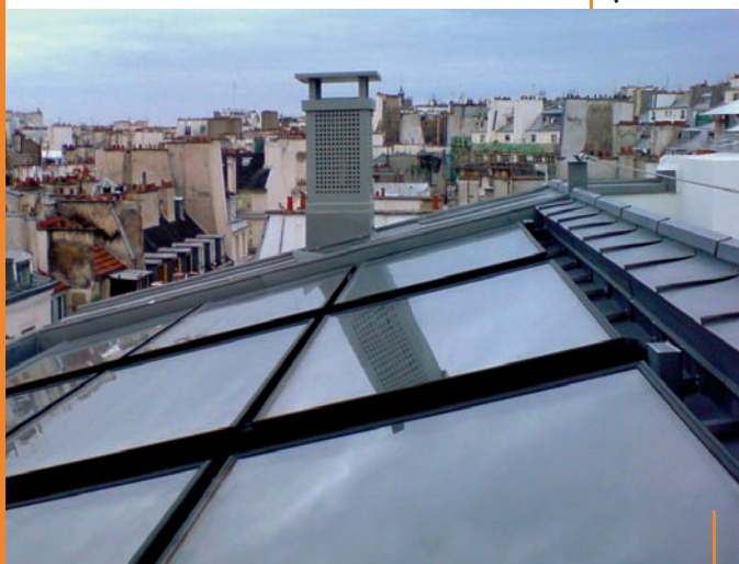
Panneaux solaires thermiques intégrés dans une toiture parisienne
