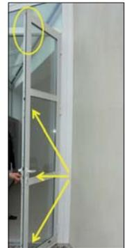
Sur une crèche, des portes « anti-pinces doigts » présentent également de grosses faiblesses d'étanchéité à l'air.
