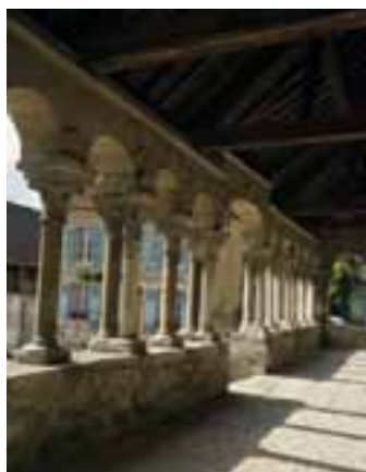
Eglise d'Hermonville Crédits photos: ©M.Jolyot - CDT Marne
