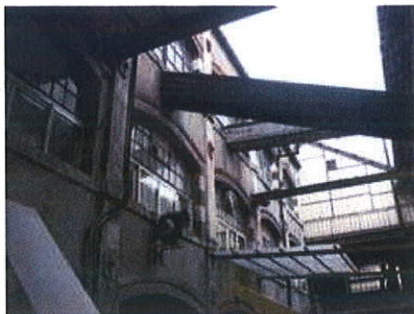
Usine DAUM Vue intérieur site de : VANNES LE CHATEL
