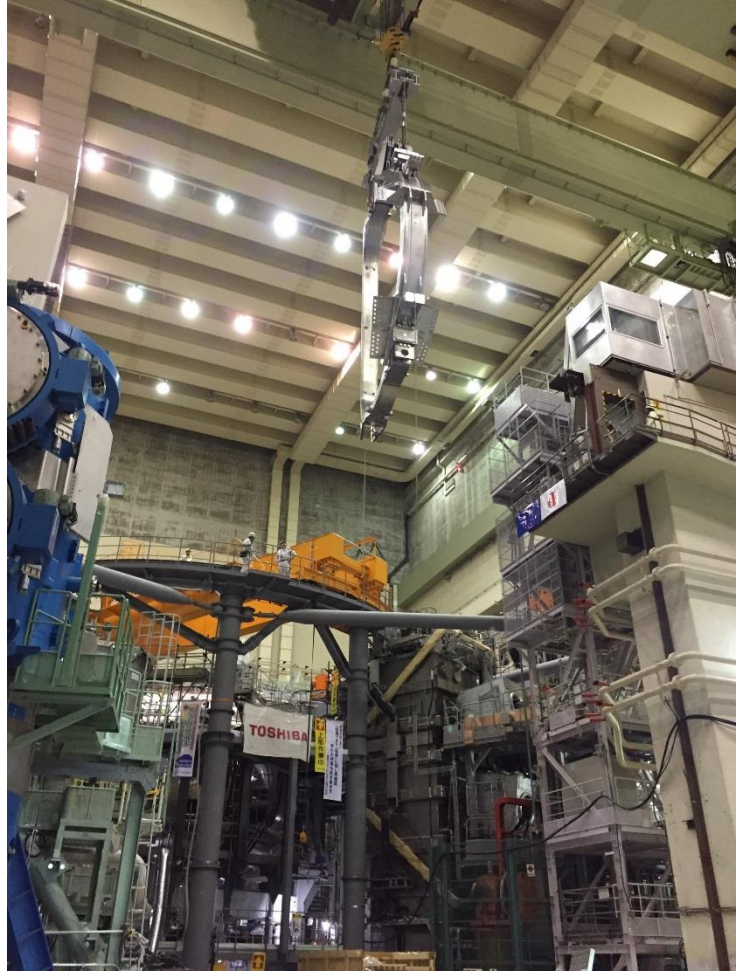
La première bobine et sa structure de liaison sont livrées au Japon et préparées pour une installation sur JT60-SA en juillet 2016. Crédits : A gauche ©
