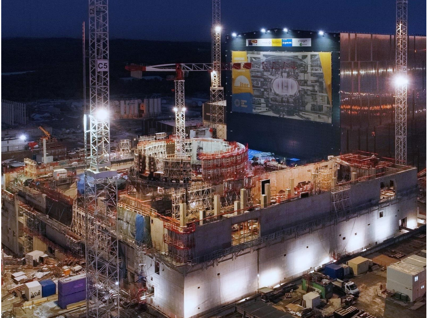
La construction des bâtiments ITER a démarré en 2010. Au cœur de la plateforme, le Complexe tokamak prend forme en décembre 2017. © ITER Organization
