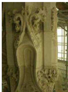
Une pierre neuve intégrée au parement du 16 ème siècle dans un motif en « cloche » caractéristique de l'architecture flamboyante de la tour
