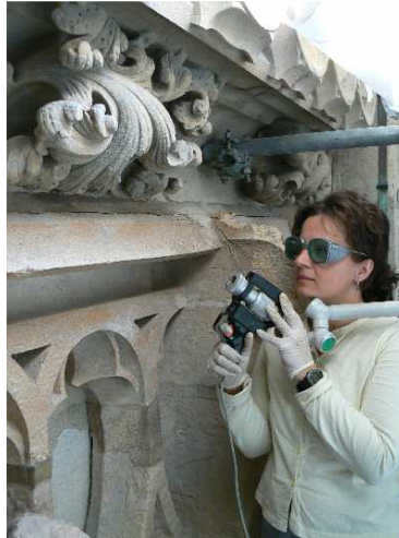
Restauratrice travaillant au laser.
