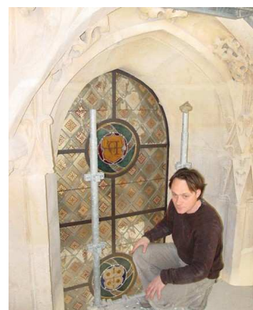
La repose sur site des vitraux
