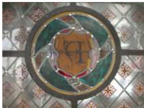
Un médaillon polychrome des vitraux après nettoyage et remise en plomb
