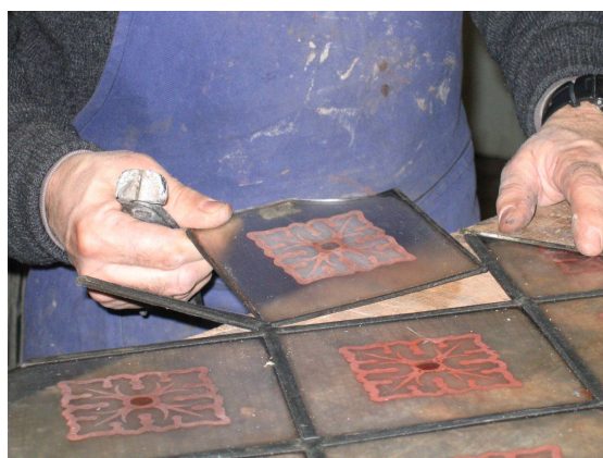
Restauration des vitraux : les pièces de verre sont enlevées une par une pour être nettoyées.
