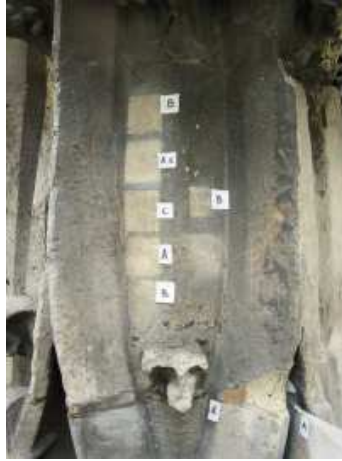
Essais de nettoyages pour déterminer le protocole adapté aux parements existants.
