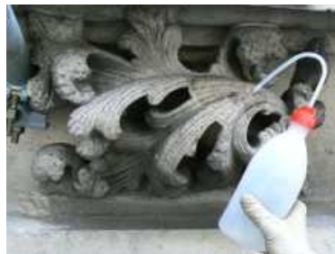
Parties trop fragiles, pré consolidées avant nettoyage
