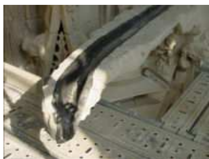
Habillage en plomb de l'écoulement d'une grande gargouille
